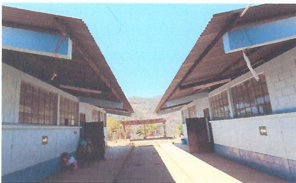
Foto 1: Estructura de techo con agujeros y deterioro de dos módulos.
